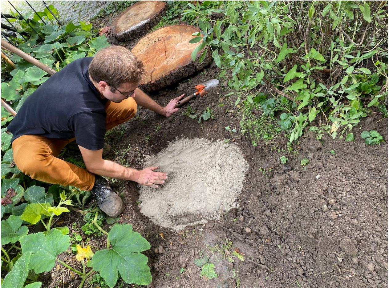
pose d'un lit de sable avant la dépose des rondins de bois.
